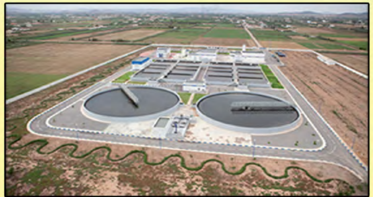
Station d'épuration des Eaux Usées - Grand Nador
